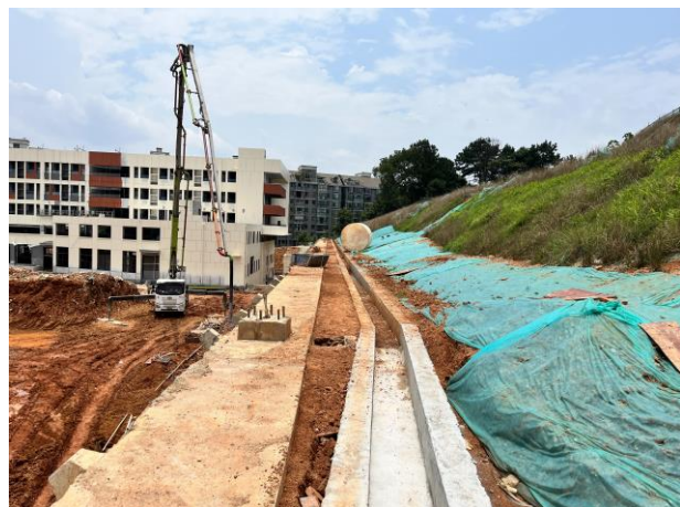
位置：排水沟砌筑
